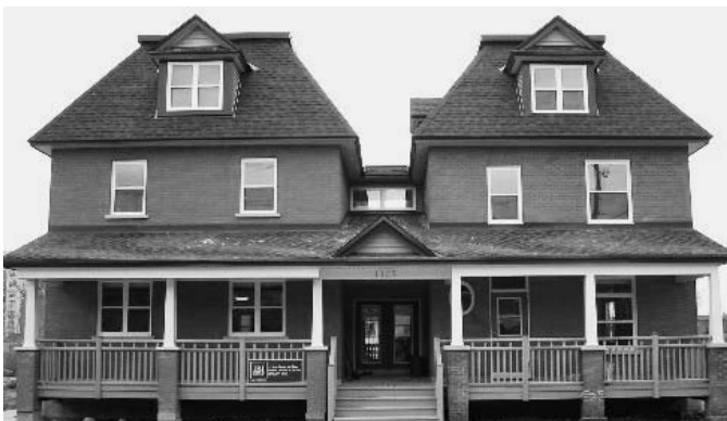
Armée du Salut Logement transitionnel
